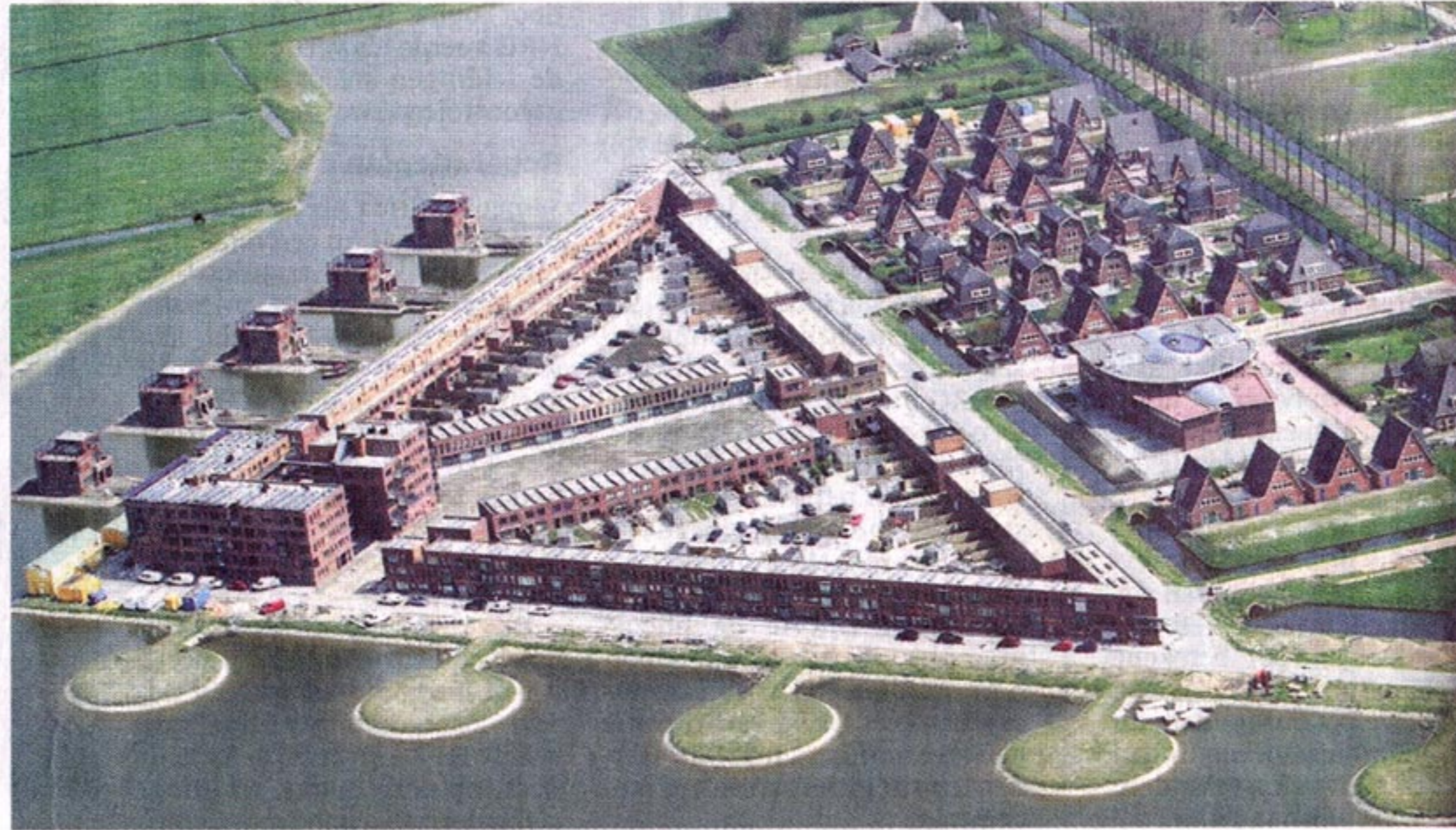
In de Stad van de Zon worden 24 woningen gebouwd die geen stookkosten hebben.
