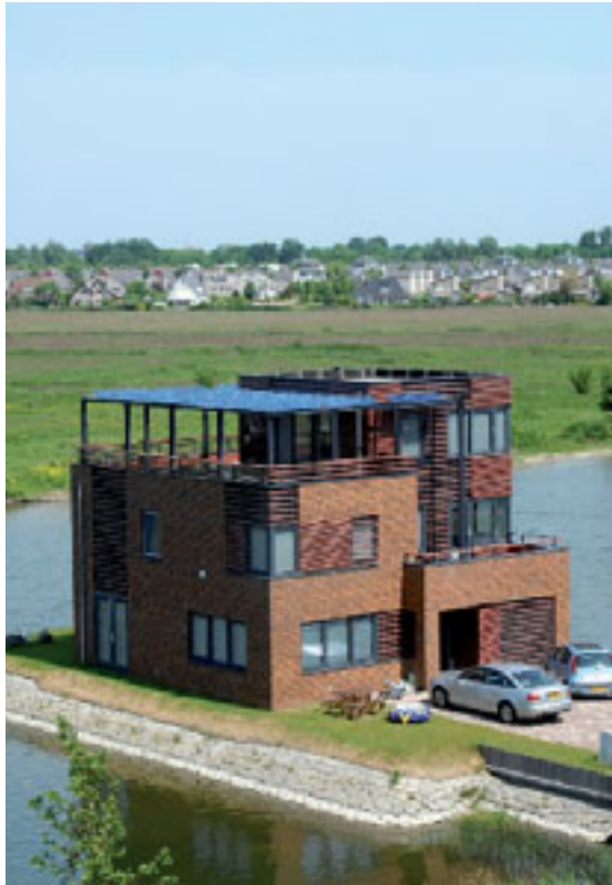
Vrijwel elke woning in de wijk heeft zonnepanelen. BOPARAI ARCHITECTEN
